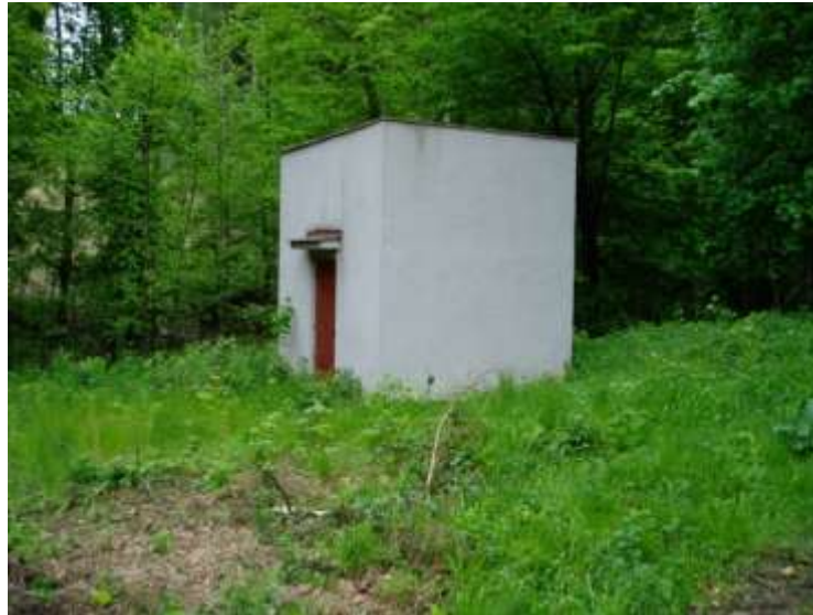
Obr.2. Armaturní objekt vrtu PH-1.
