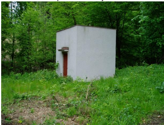
Obr.2. Zděný armaturní objekt vrtu PH-1.
